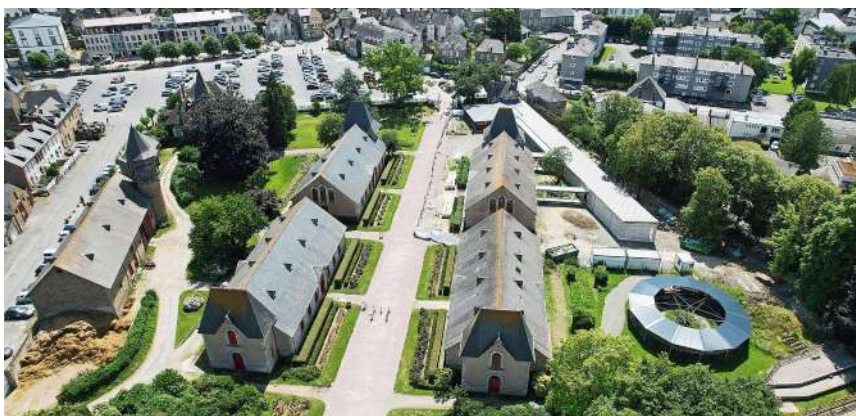
Vue aérienne du chantier (en haut à droite) - cliché Arnaud Delattre
